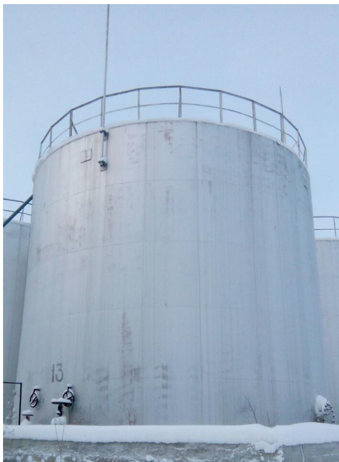
Рисунок 1 - Общий вид резервуара РВС-400
