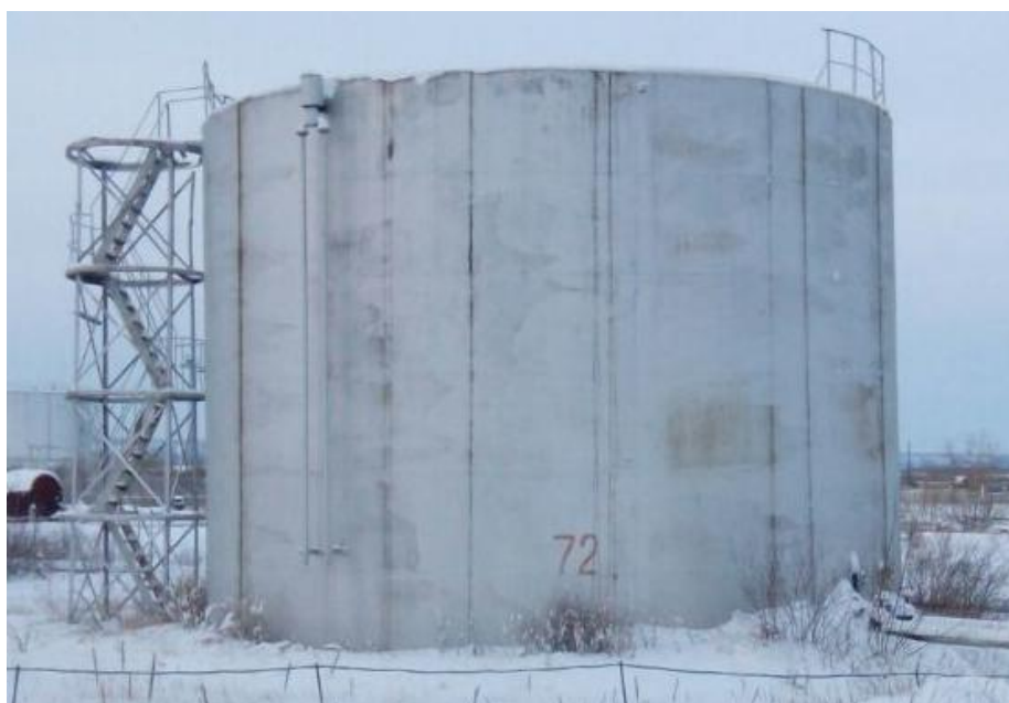
Рисунок 3 - Общий вид резервуара РВС-1000
