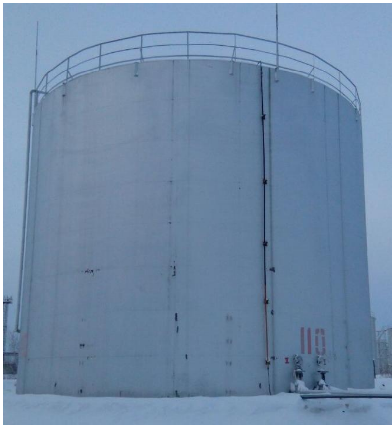
Рисунок 4 - Общий вид резервуара РВС-2000
