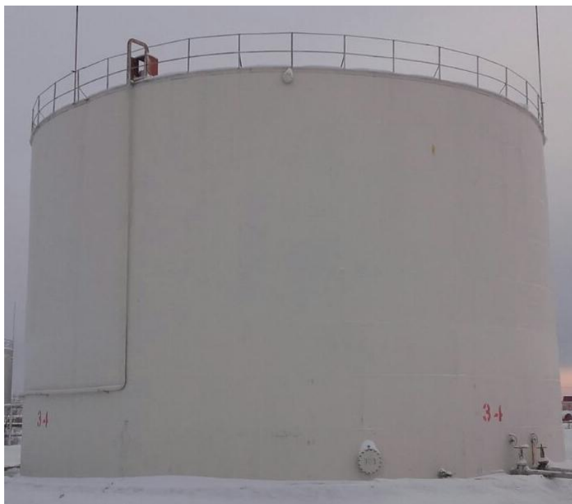
Рисунок 5 - Общий вид резервуара РВС-3000
