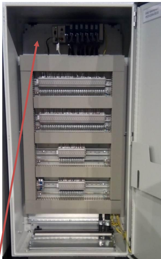
Рисунок 8 - Шкаф термопарный 2
