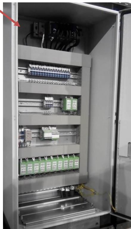
Рисунок 10 - Шкаф аналоговых сигналов 2
