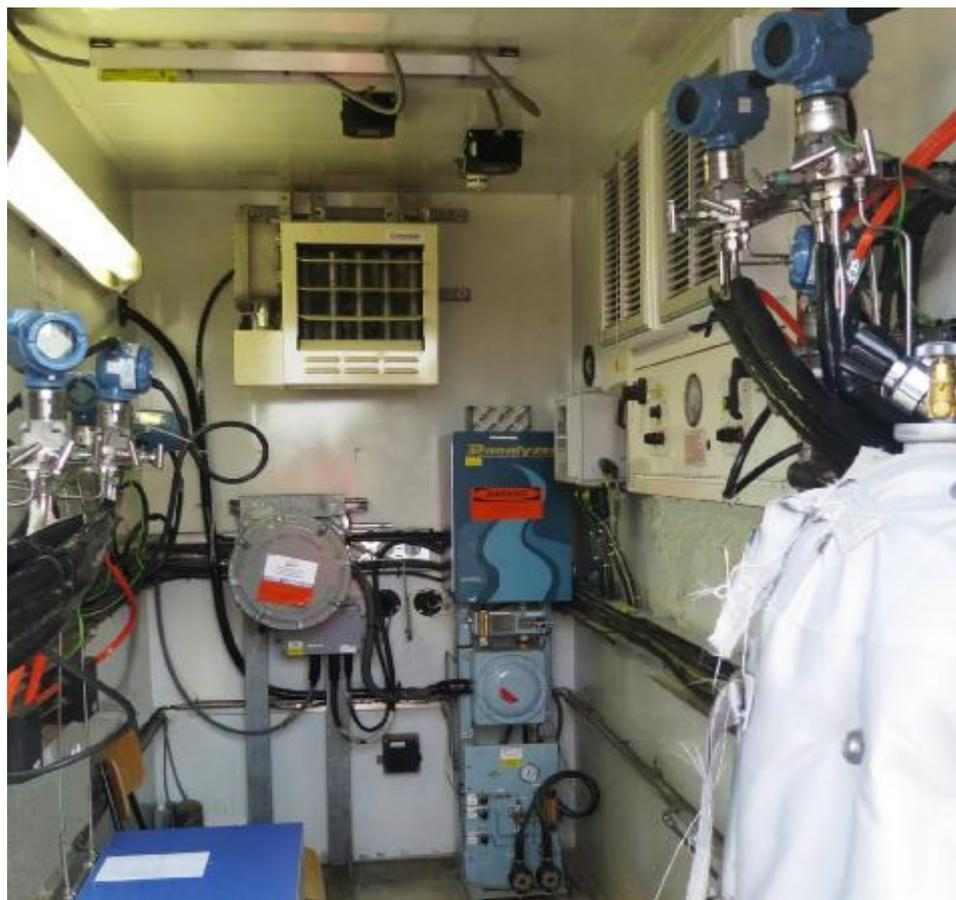
Рисунок 2 - Общий вид средств измерений, расположенных в теплоизолированном боксе
