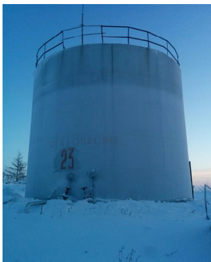
Рисунок 2 - Общий вид резервуара РВС-400
