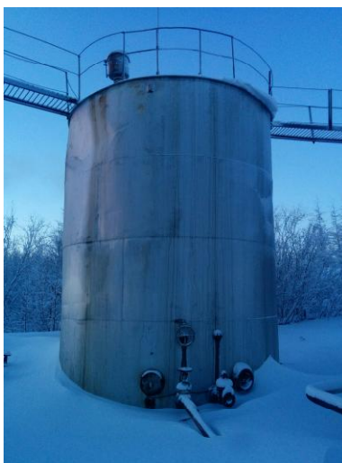
Рисунок 1 - Общий вид резервуара РВС-100
