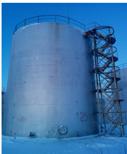
Рисунок 4 - Общий вид резервуара РВС-1000
