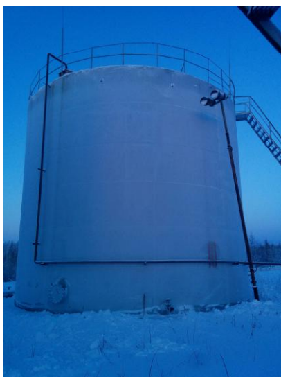
Рисунок 3 - Общий вид резервуара РВС-700
