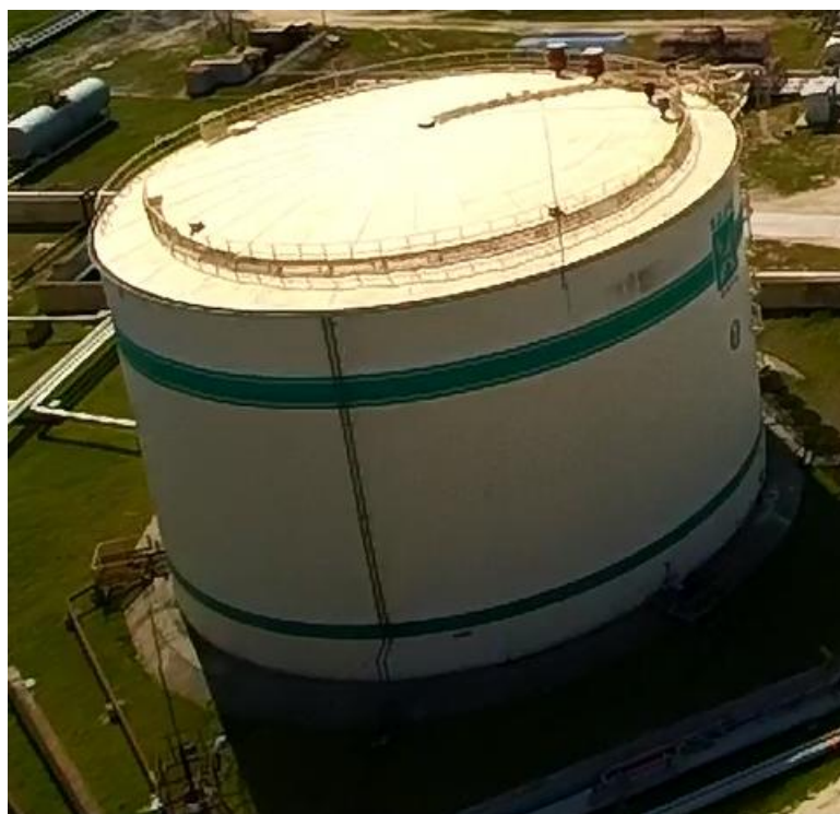
Рисунок 1- Общий вид резервуара РВС-10000
