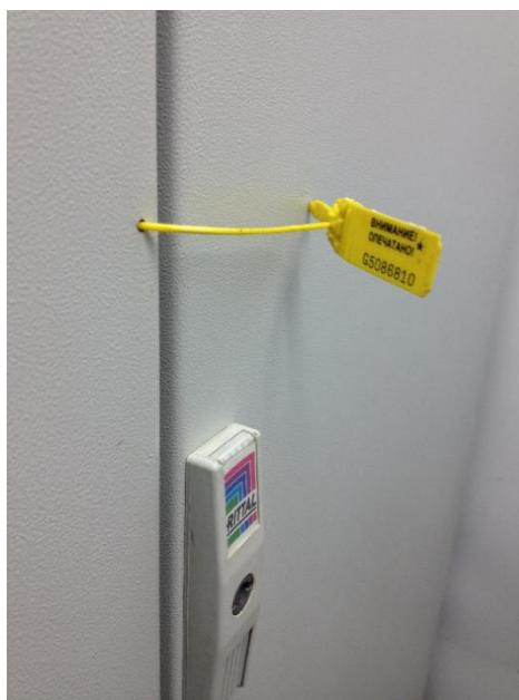
Рисунок 2 - Пломбировка шкафа СОИ
