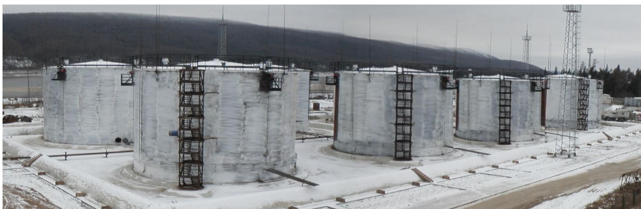
Рисунок 1 - Общий вид резервуаров
