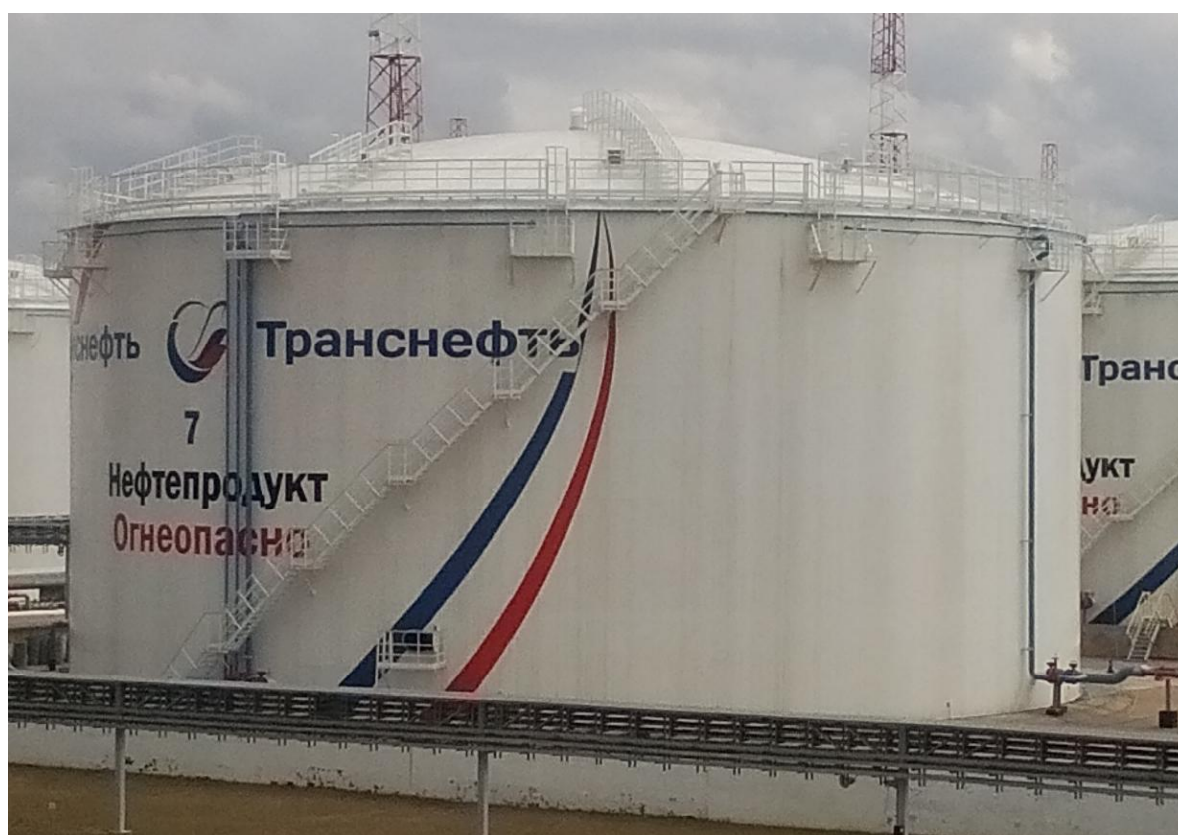
Рисунок 2 - Общий вид резервуара вертикального стального цилиндрического PBCP-20000
