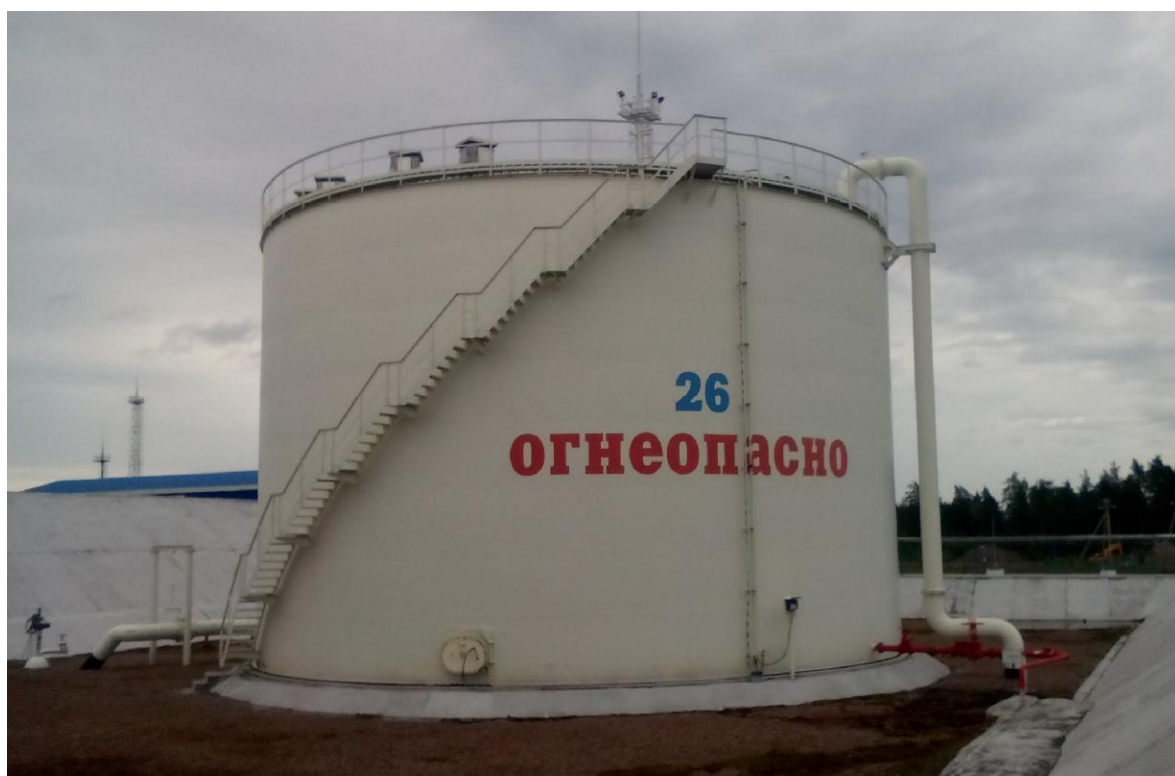
Рисунок 1 - Общий вид резервуара вертикального стального цилиндрического PBC-3000
