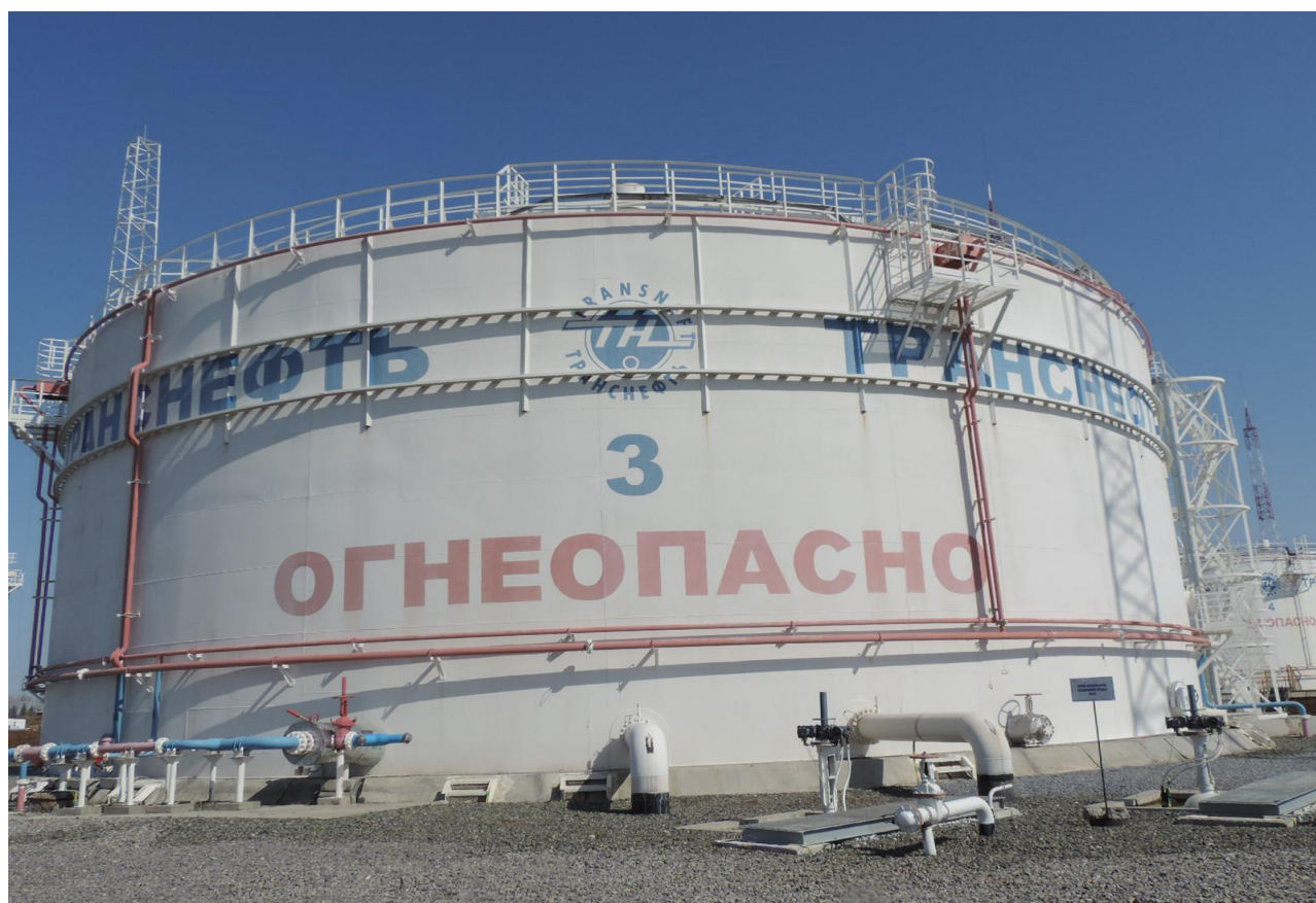
Рисунок 7 - Общий вид резервуара вертикального стального цилиндрического РВСП-10000
