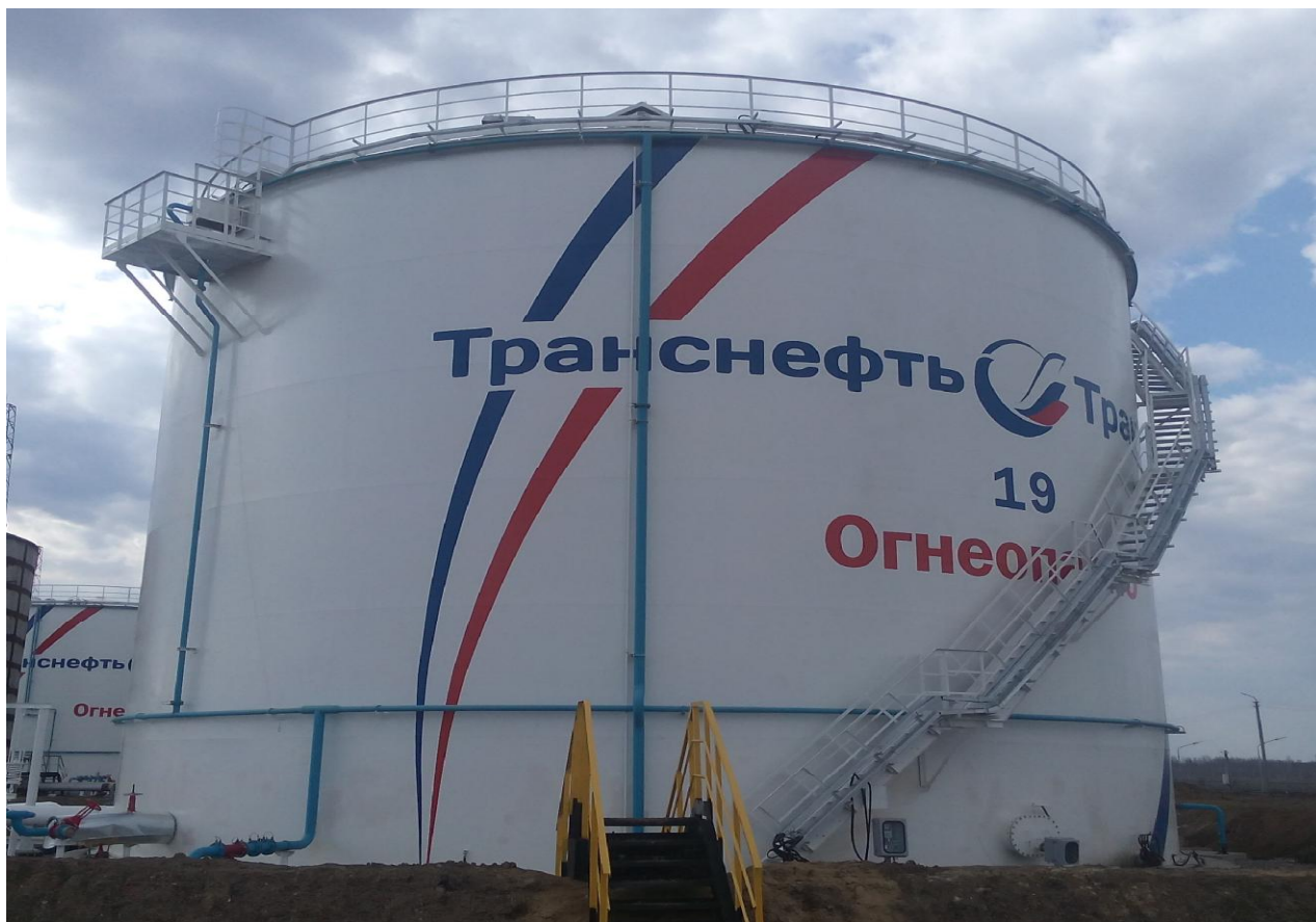
Рисунок 4 - Общий вид резервуара вертикального стального цилиндрического РВС-5000
