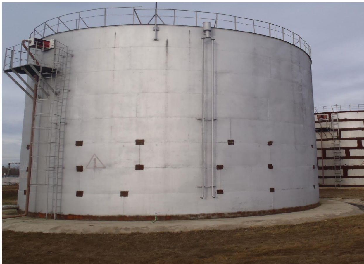
Рисунок 3 - Общий вид резервуара вертикального стального цилиндрического РВС-2000
