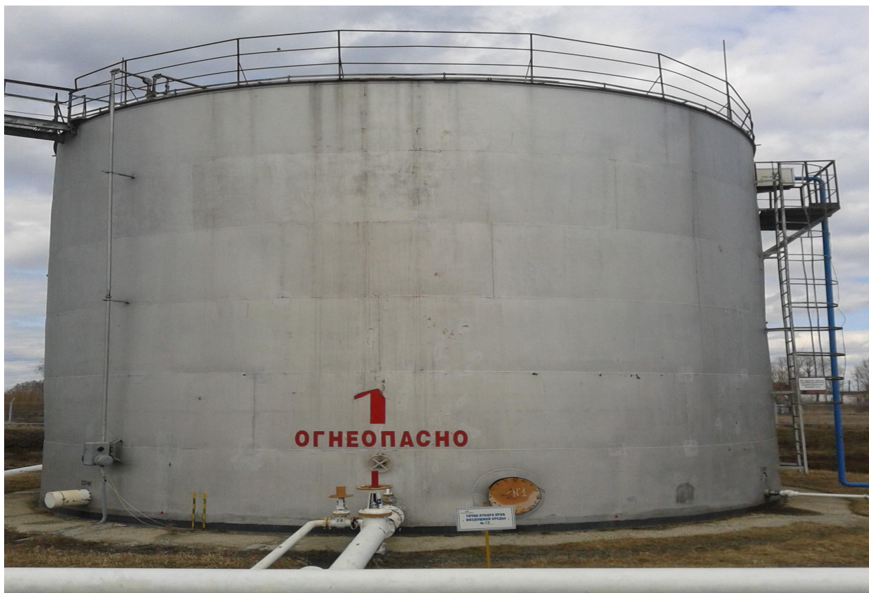
Рисунок 2 - Общий вид резервуара вертикального стального цилиндрического РВС-1000
