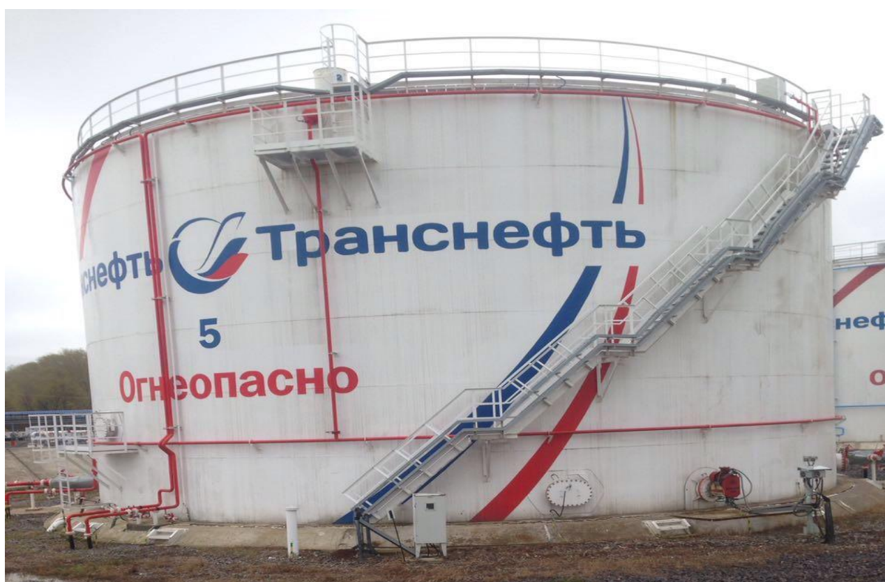
Рисунок 5 - Общий вид резервуара вертикального стального цилиндрического РВСП-5000
