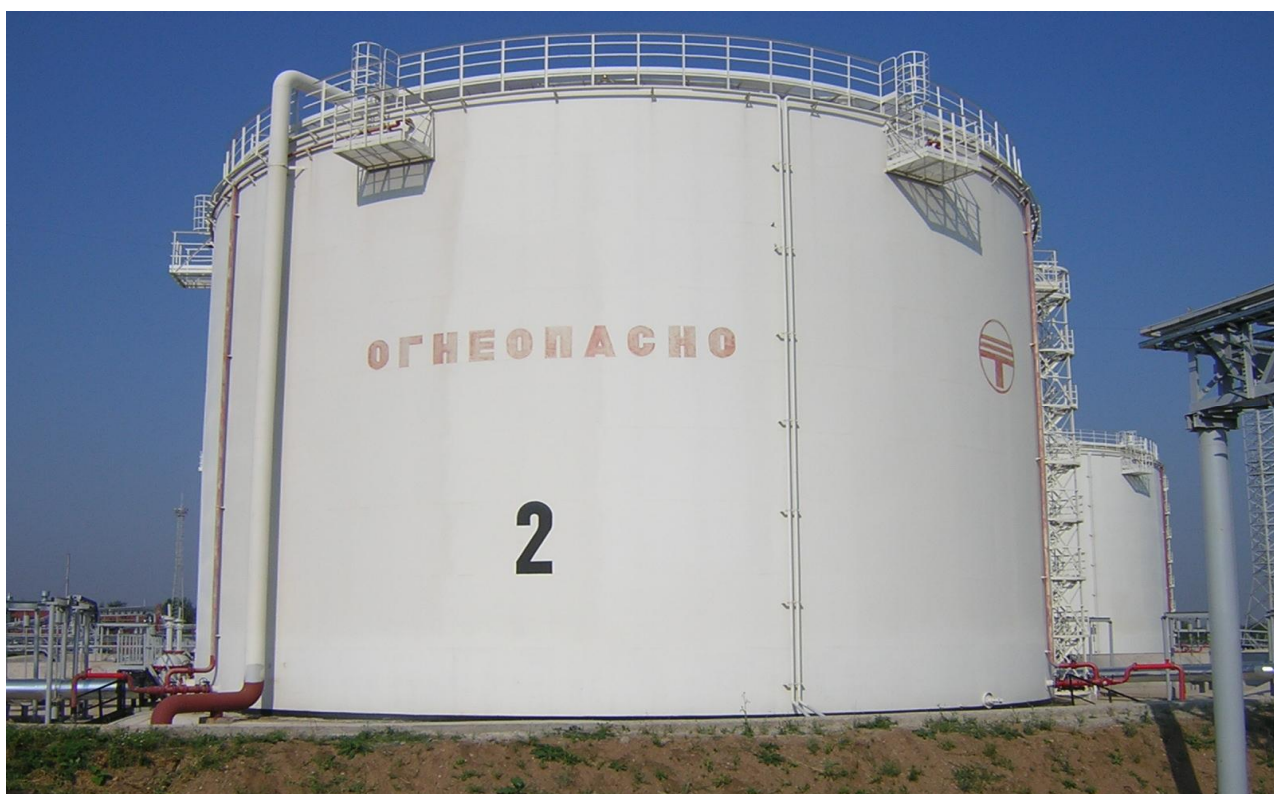
Рисунок 6 - Общий вид резервуара вертикального стального цилиндрического РВС-10000
