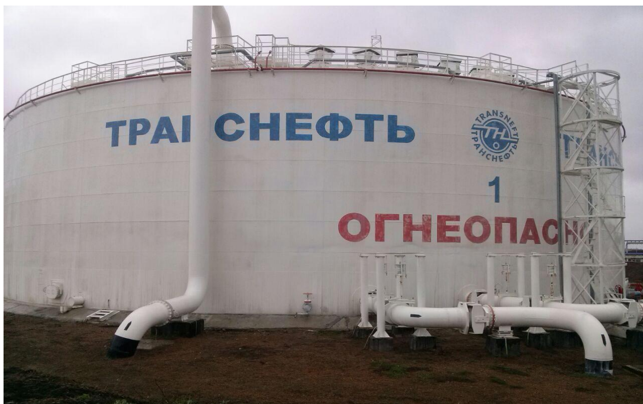
Рисунок 8 - Общий вид резервуара вертикального стального цилиндрического РВС-20000
