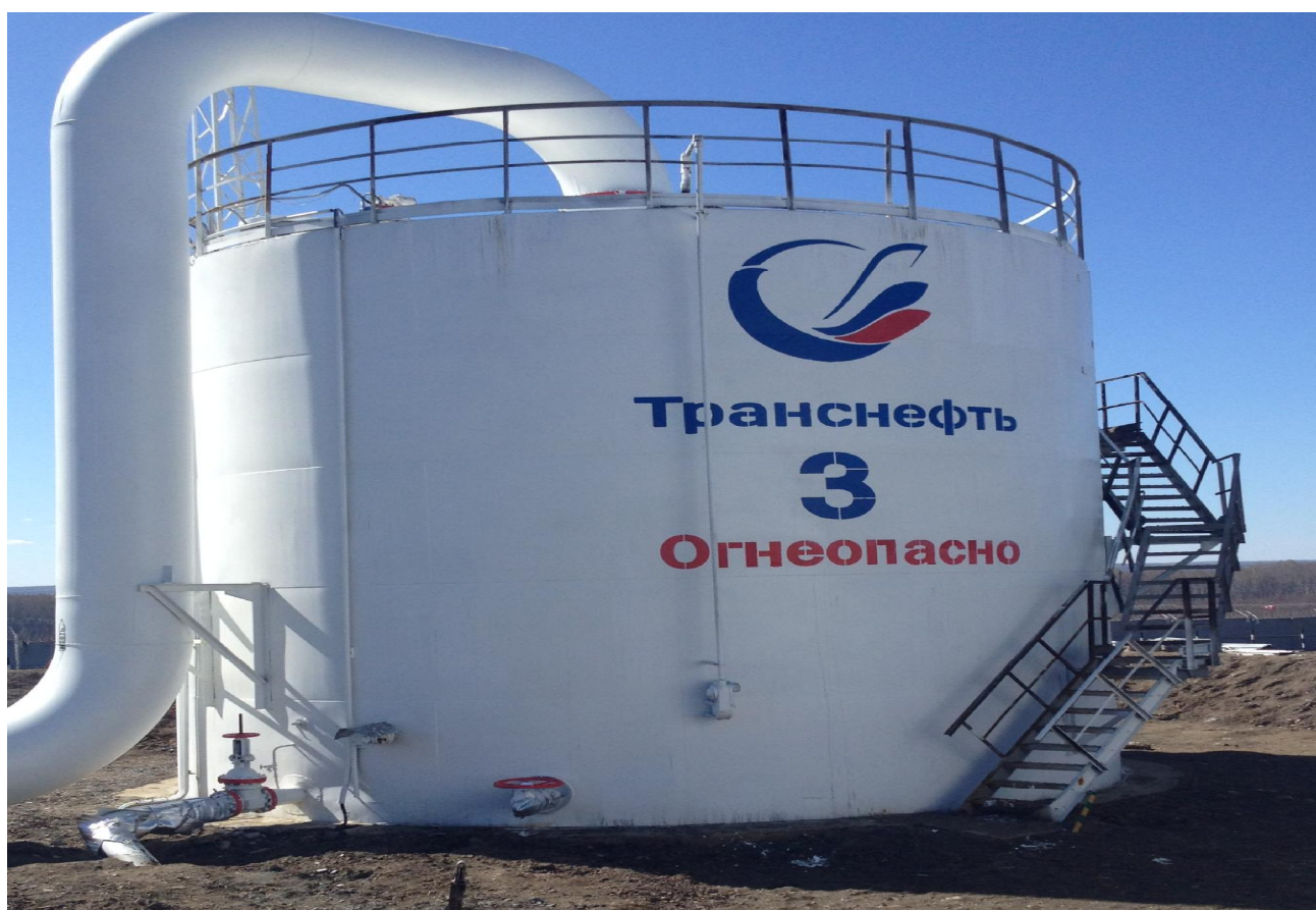
Рисунок 1 - Общий вид резервуара вертикального стального цилиндрического РВС-400
