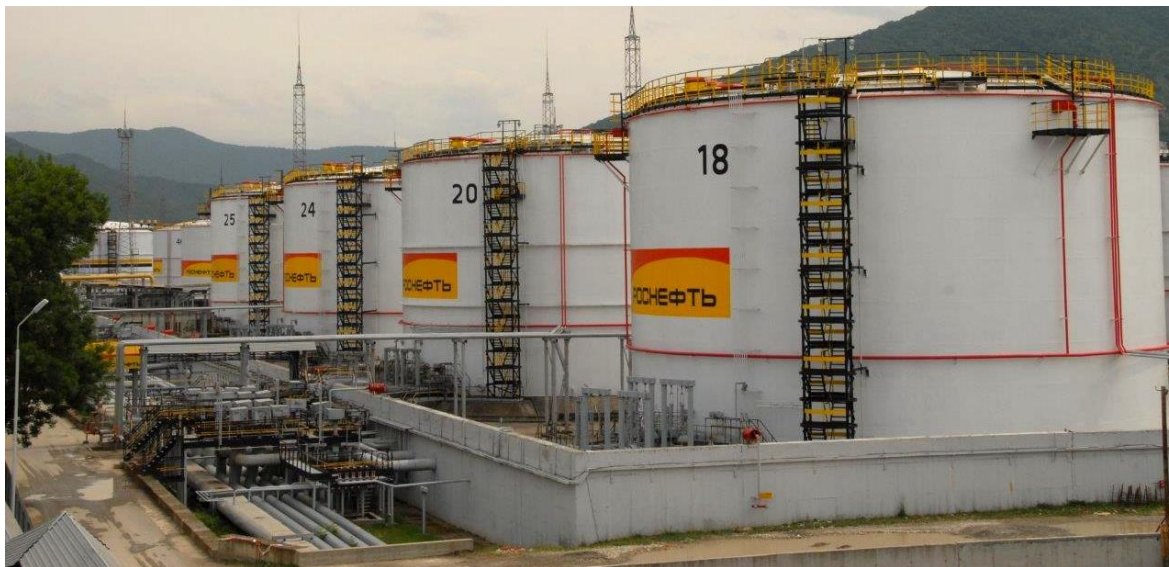
Рисунок 1 - Общий вид резервуаров
