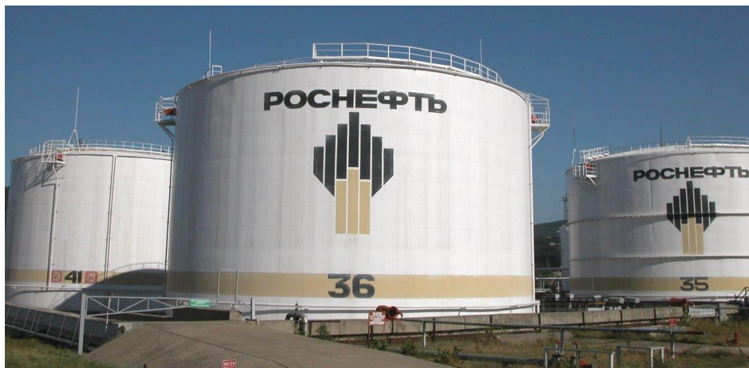
Рисунок 1 - Общий вид резервуаров
