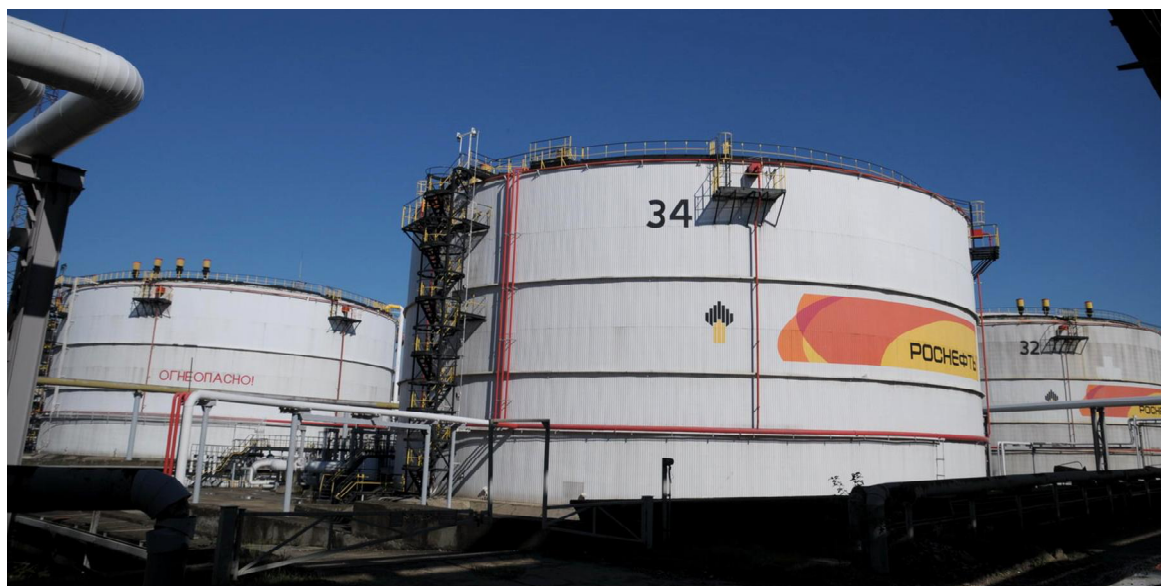
Рисунок 1 - Общий вид резервуаров
