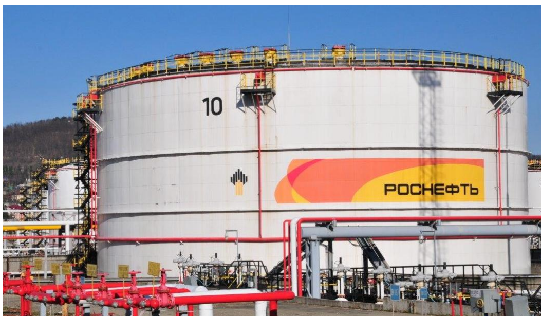
Рисунок 1 - Общий вид резервуаров
