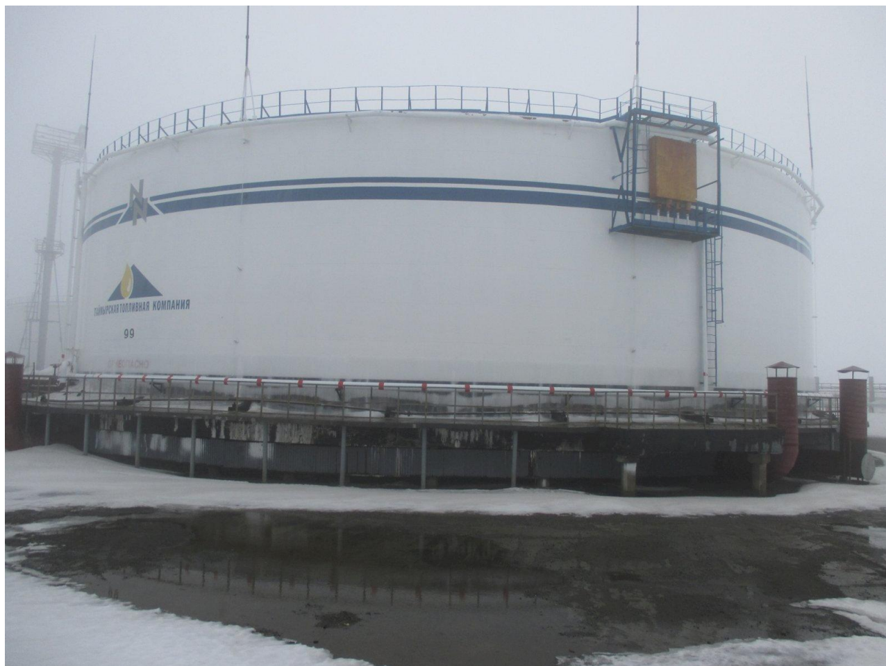
Рисунок 3 - Общий вид резервуара вертикального стального цилиндрического РВС-20000
