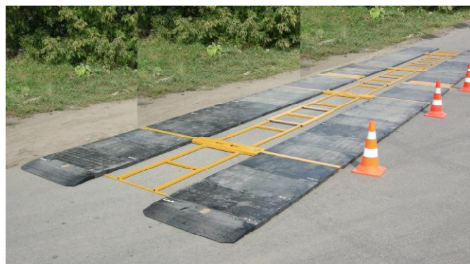
а) Установка ГПУ систем на поверхности
