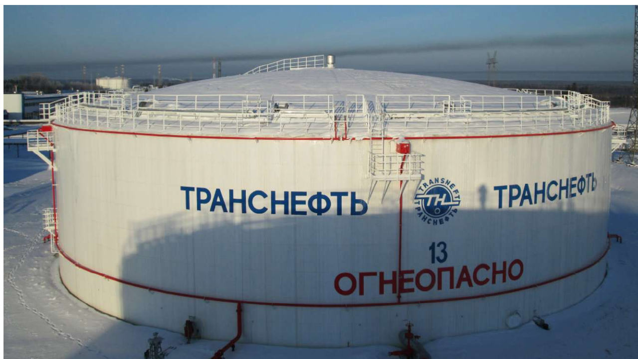
Рисунок 7 - Общий вид резервуара вертикального стального цилиндрического РВСП-20000
