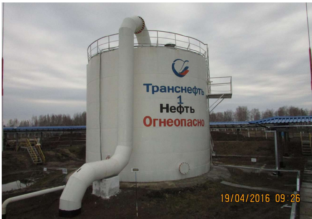
Рисунок 1 - Общий вид резервуара вертикального стального цилиндрического РВС-400
