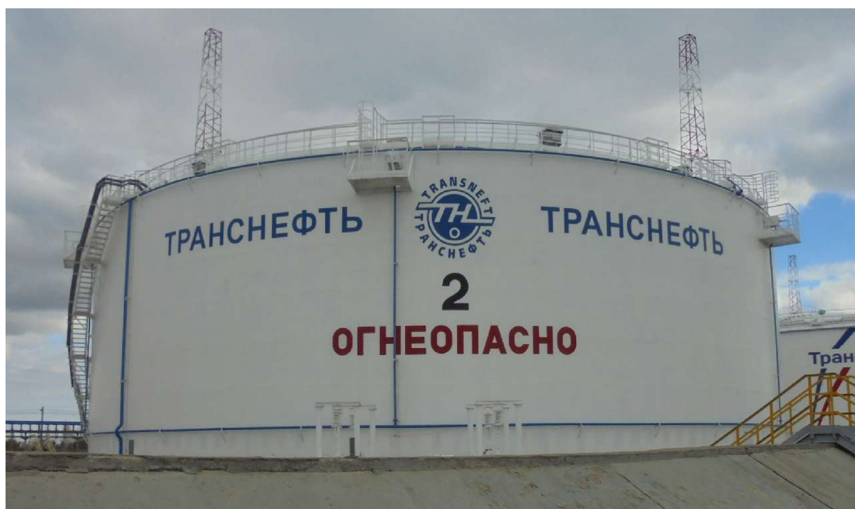
Рисунок 2 - Общий вид резервуара вертикального стального цилиндрического РВС-20000
