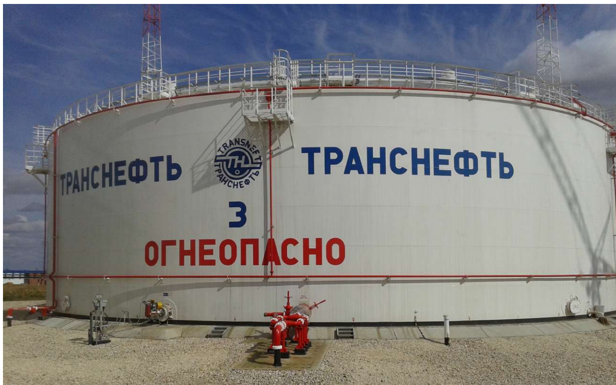
Рисунок 3 - Общий вид резервуара вертикального стального цилиндрического РВСП-20000
