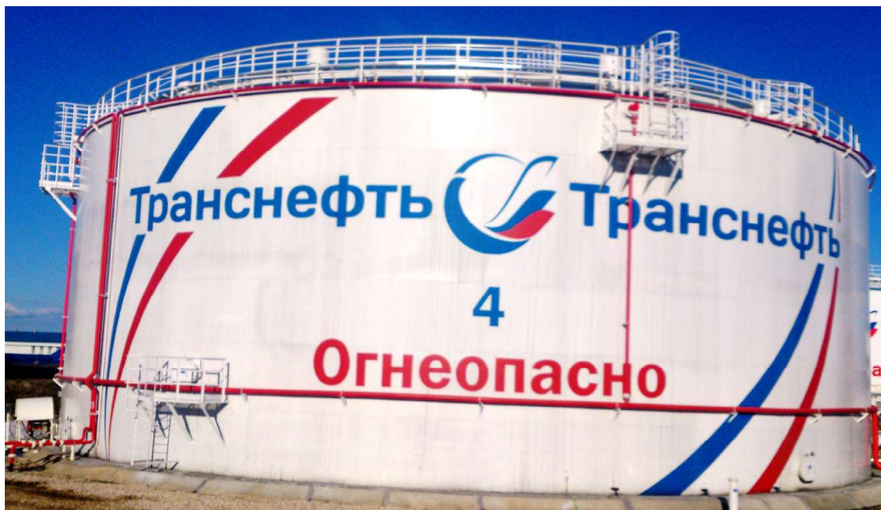
Рисунок 2 - Общий вид резервуара вертикального стального цилиндрического РВСП-10000
