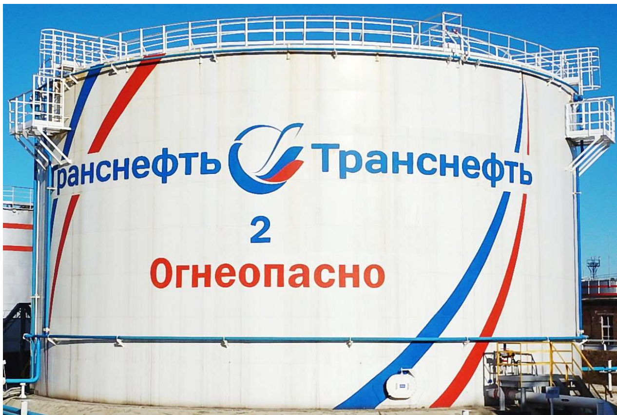
Рисунок 1 - Общий вид резервуара вертикального стального цилиндрического РВС-5000
