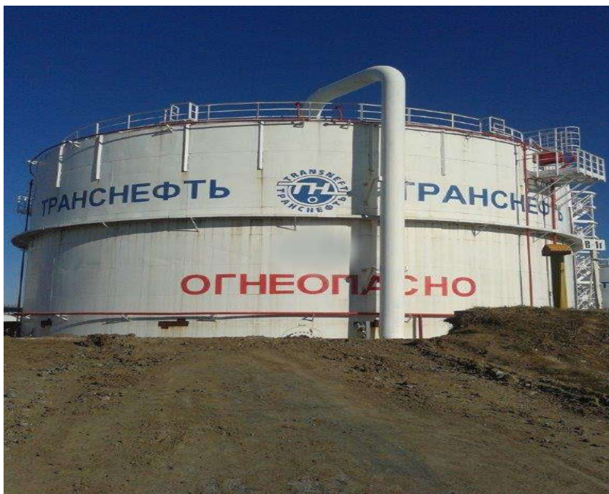
Рисунок 1 - Общий вид резервуара вертикального стального цилиндрического РВС-5000
