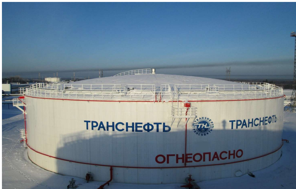
Рисунок 3 - Общий вид резервуара вертикального стального цилиндрического РВСП-50000
