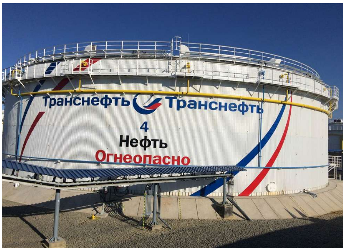
Рисунок 2 - Общий вид резервуара вертикального стального цилиндрического РВСП-20000
