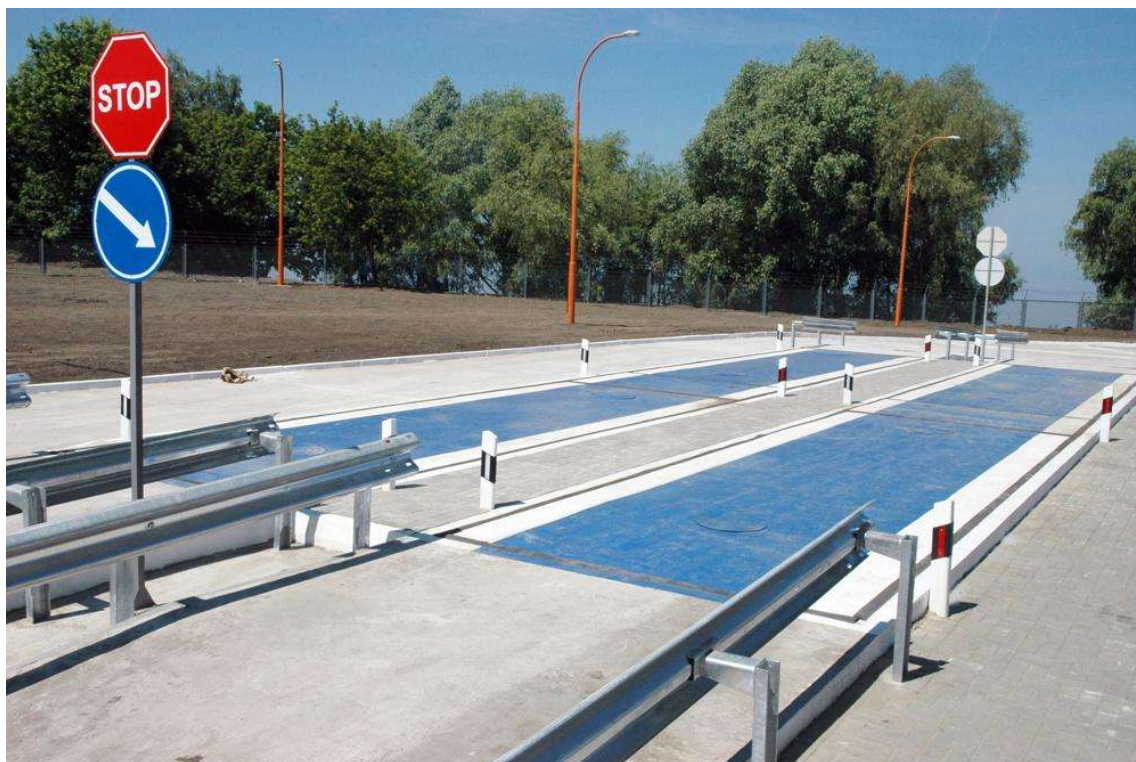
Рисунок 1 - Общий вид ГПУ весов
