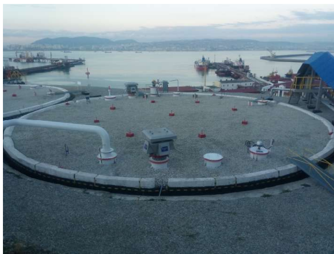
Рисунок 1 - Общий вид резервуара
