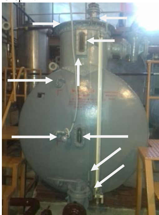
Рисунок 1 - Общий вид и места пломбирования мерника
