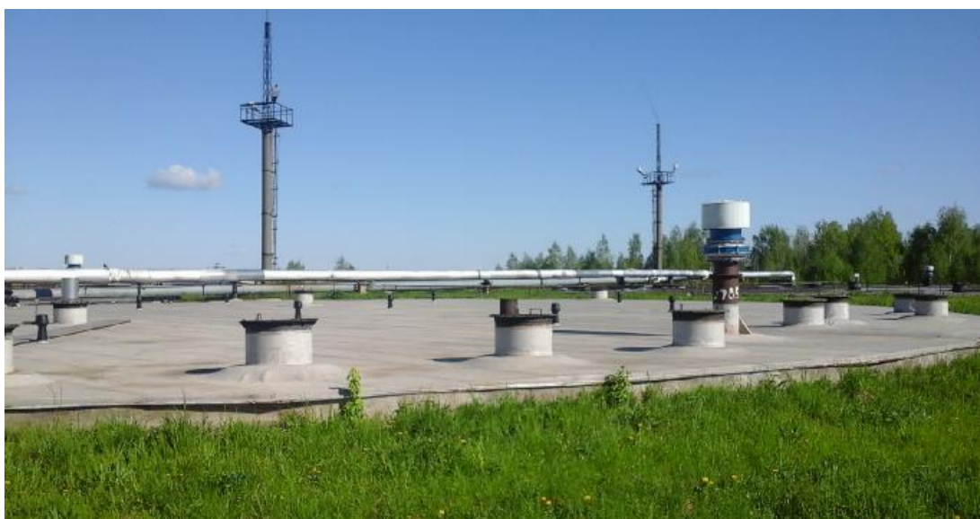
Рисунок 1 - Общий вид резервуара ЖБР-10000 №2
