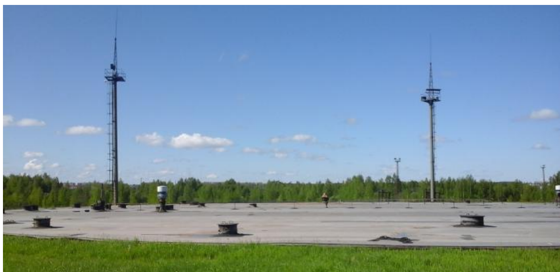
Рисунок 3 - Общий вид резервуара ЖБР-20000 №21
