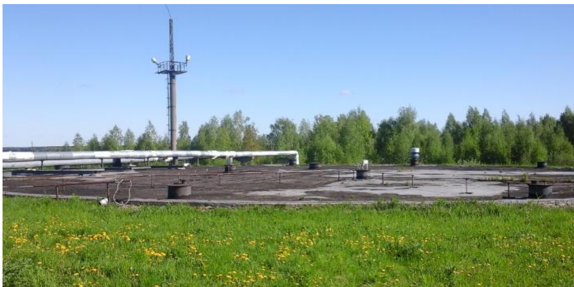
Рисунок 2 - Общий вид резервуара ЖБР-10000 №3
