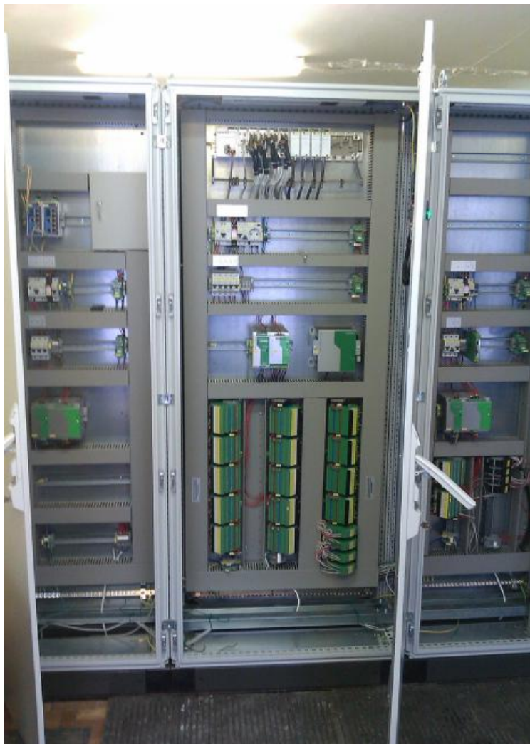
Рисунок 1 - Фотография общего вида шкафов с контролерами и модулями ввода-вывода, питания, преобразователей и других элементов в шкафу с контроллерным оборудованием
