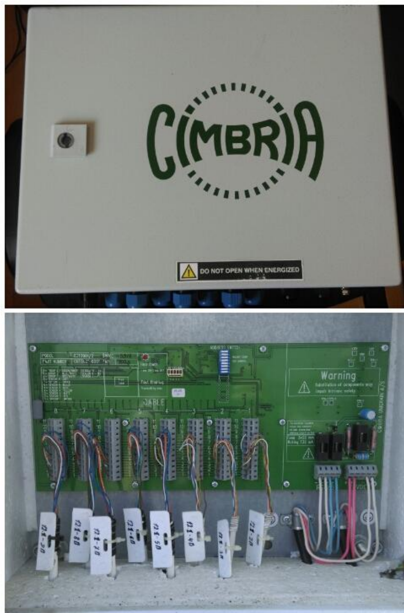
Рисунок 2. Плата распределительная CUT 3001/3 в защитном шкафу CUT 1017-0000
