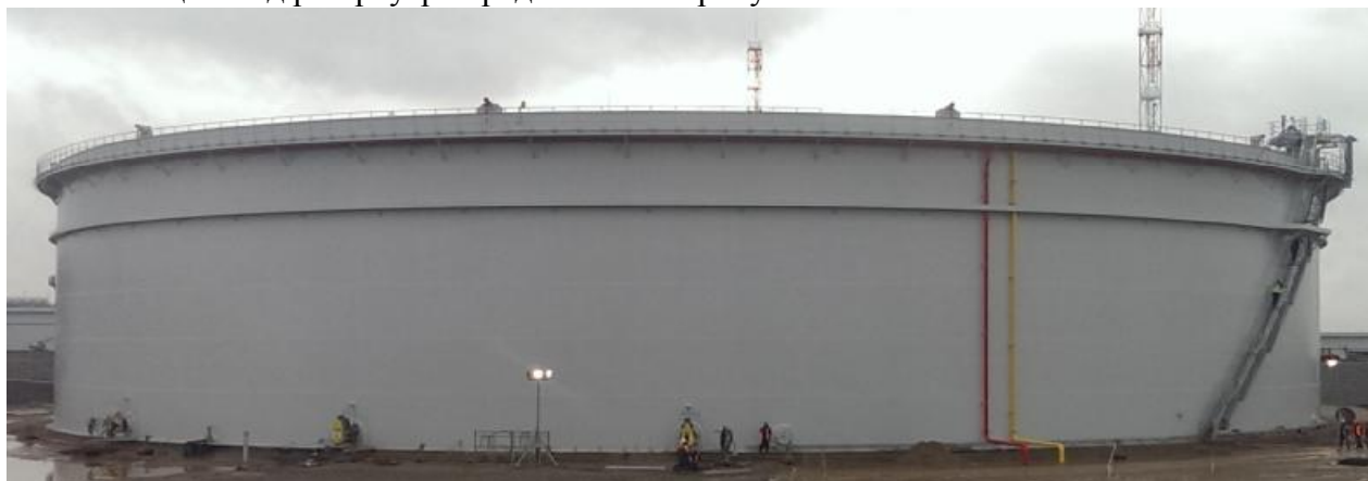
Рисунок 1 - общий вид резервуара
