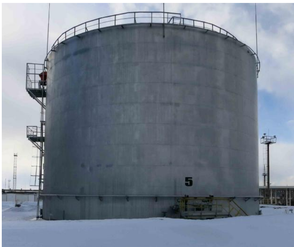
Рисунок 1 – Общий вид резервуаров РВС-5000
