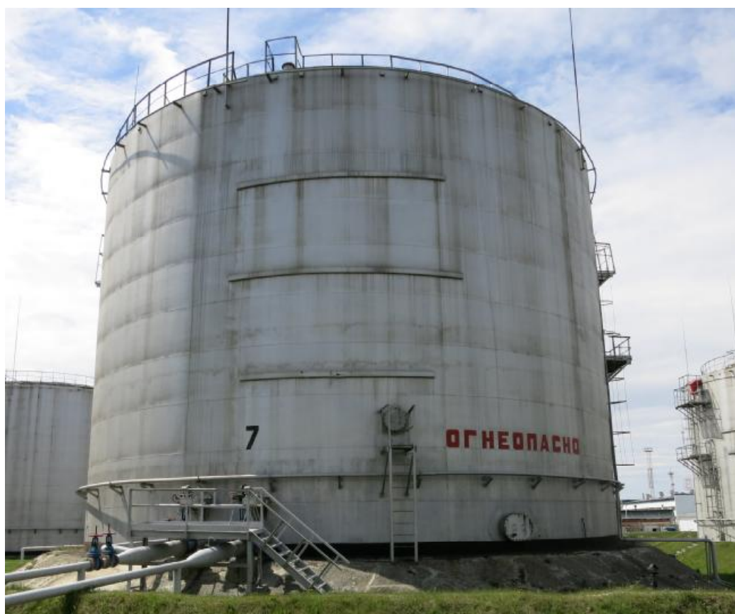
Рисунок 2 – Общий вид резервуаров РВСП-5000
