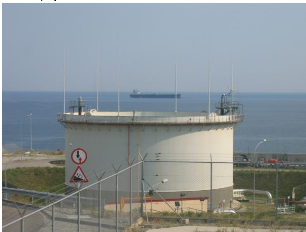
Рисунок 1 – Общий вид резервуаров РВСПК-10000
