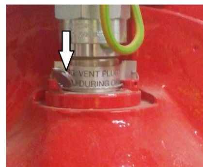
Рисунок 17 - Места пломбирования счетчиков жидкости камерных лопастных Smith Meter
