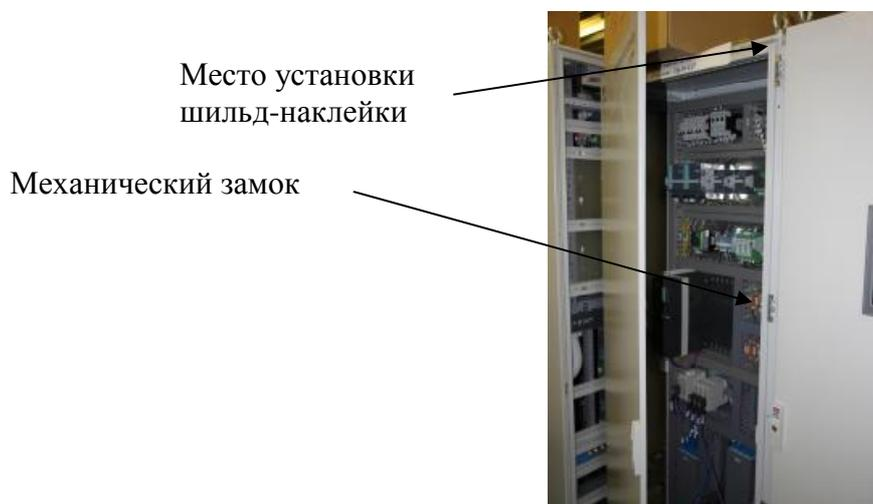
Рисунок 1 - Контроллер в приборном шкафу
