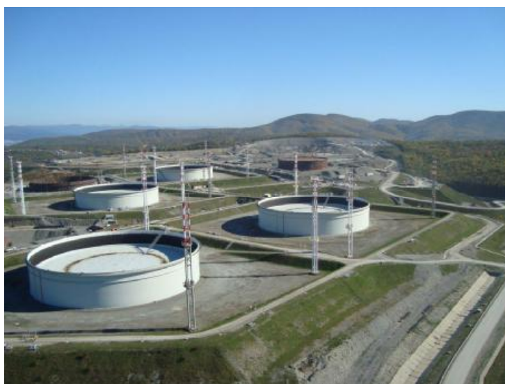
Рисунок 1 – Общий вид резервуара
