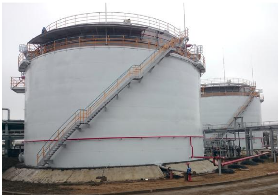
Рисунок 1 – Общий вид резервуара
