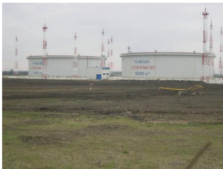
Рисунок 1 – Общий вид резервуара
