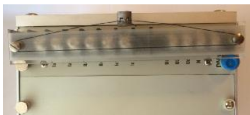
Рисунок 9 - Пломбировка клеммных соединителей измерительных цепей
