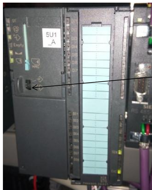
Рисунок 3 – Схема пломбирования модуля многофункционального SIWAREX FTA
