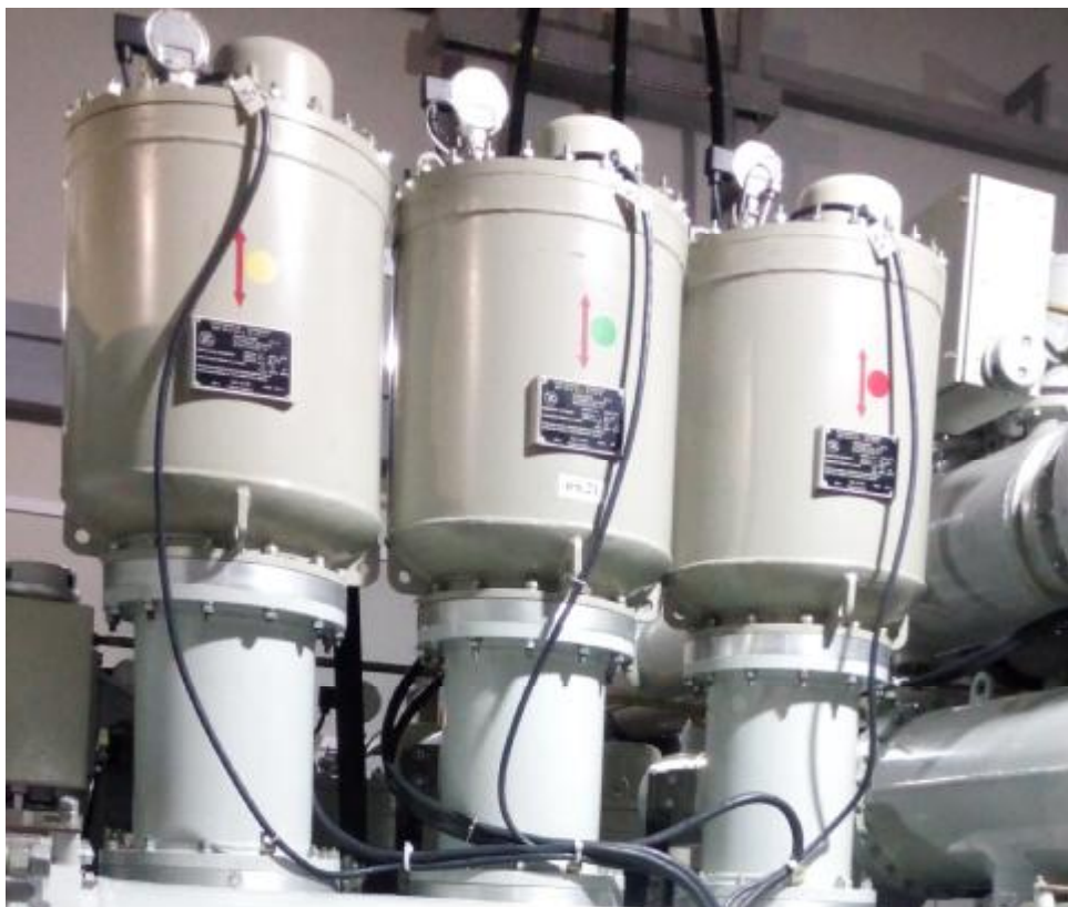
Рисунок 1 – Внешний вид трансформатора напряжения ЗНОГ-110 – IV УХЛ 4
