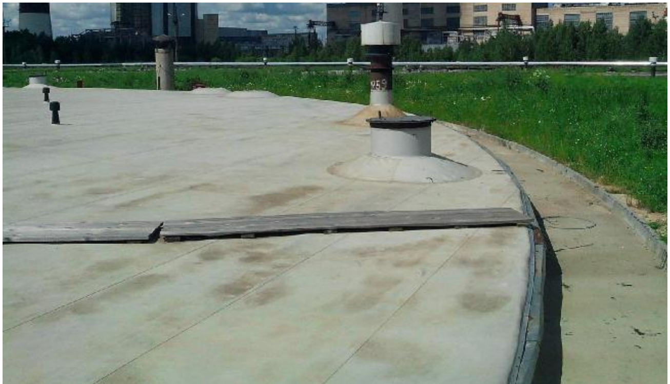
Фото 1. Общий вид резервуара.
