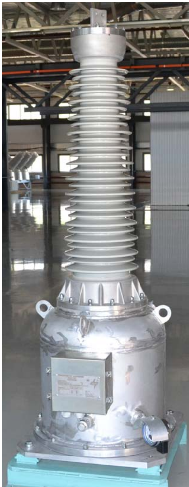
Рисунок 1 - Общий вид трансформаторов напряжения ЗНОГ
