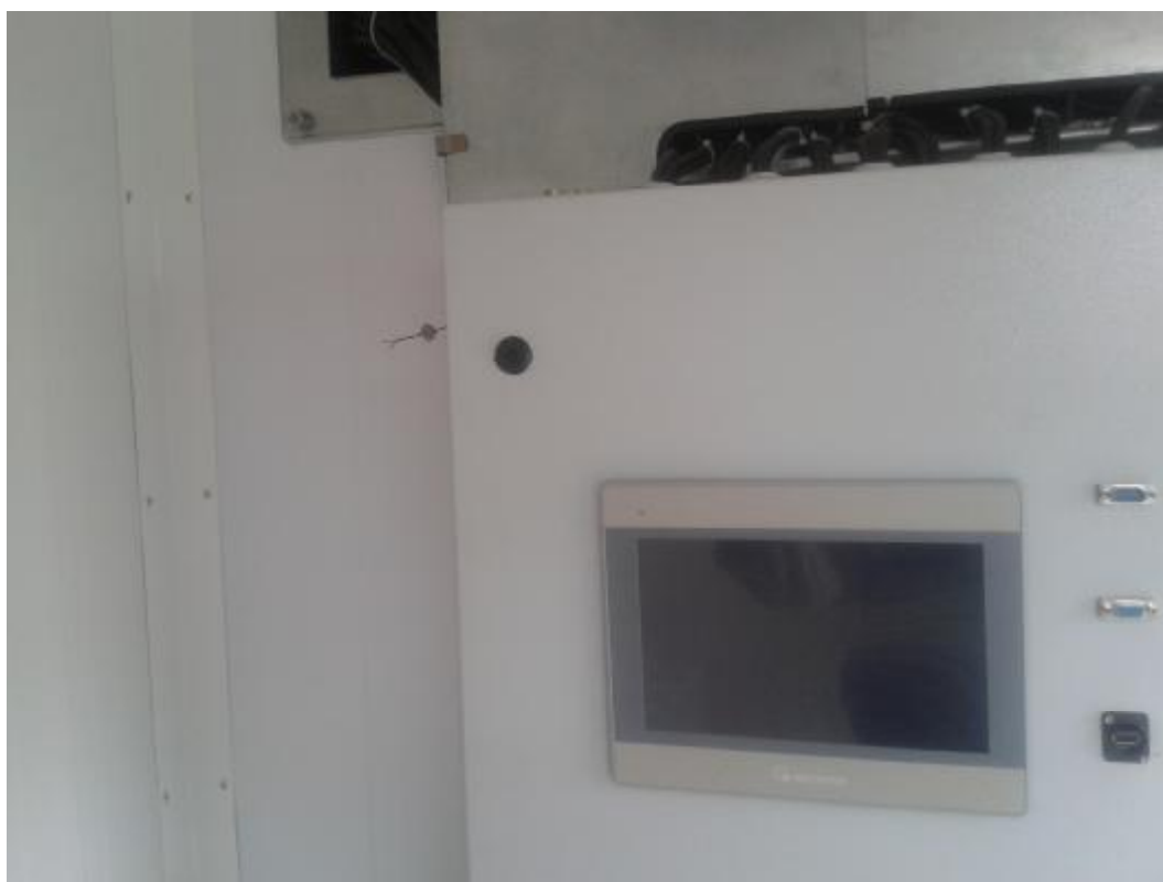
Рисунок 3 - Пломбирование и защита от несанкционированного доступа
