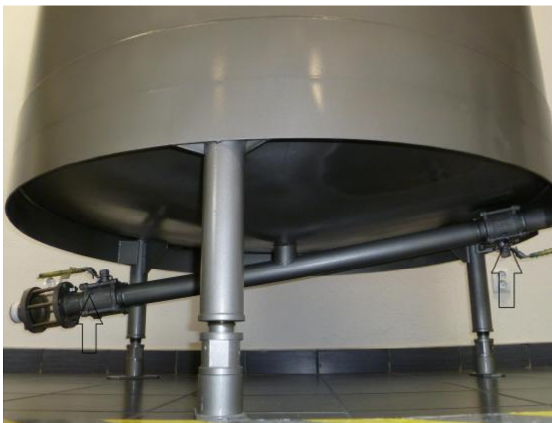
Рисунок 2-3 Места пломбировки от несанкционированного доступа
