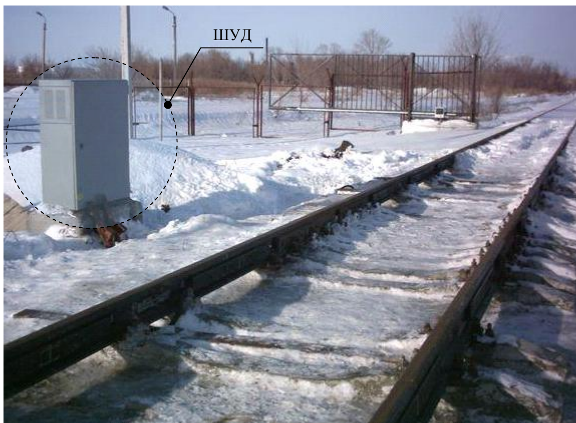
Рисунок 4 – Внешний вид ШУД в уличном исполнении
