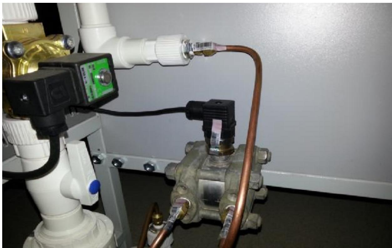
Рисунок 2 - Пломбирования датчика разности давления
