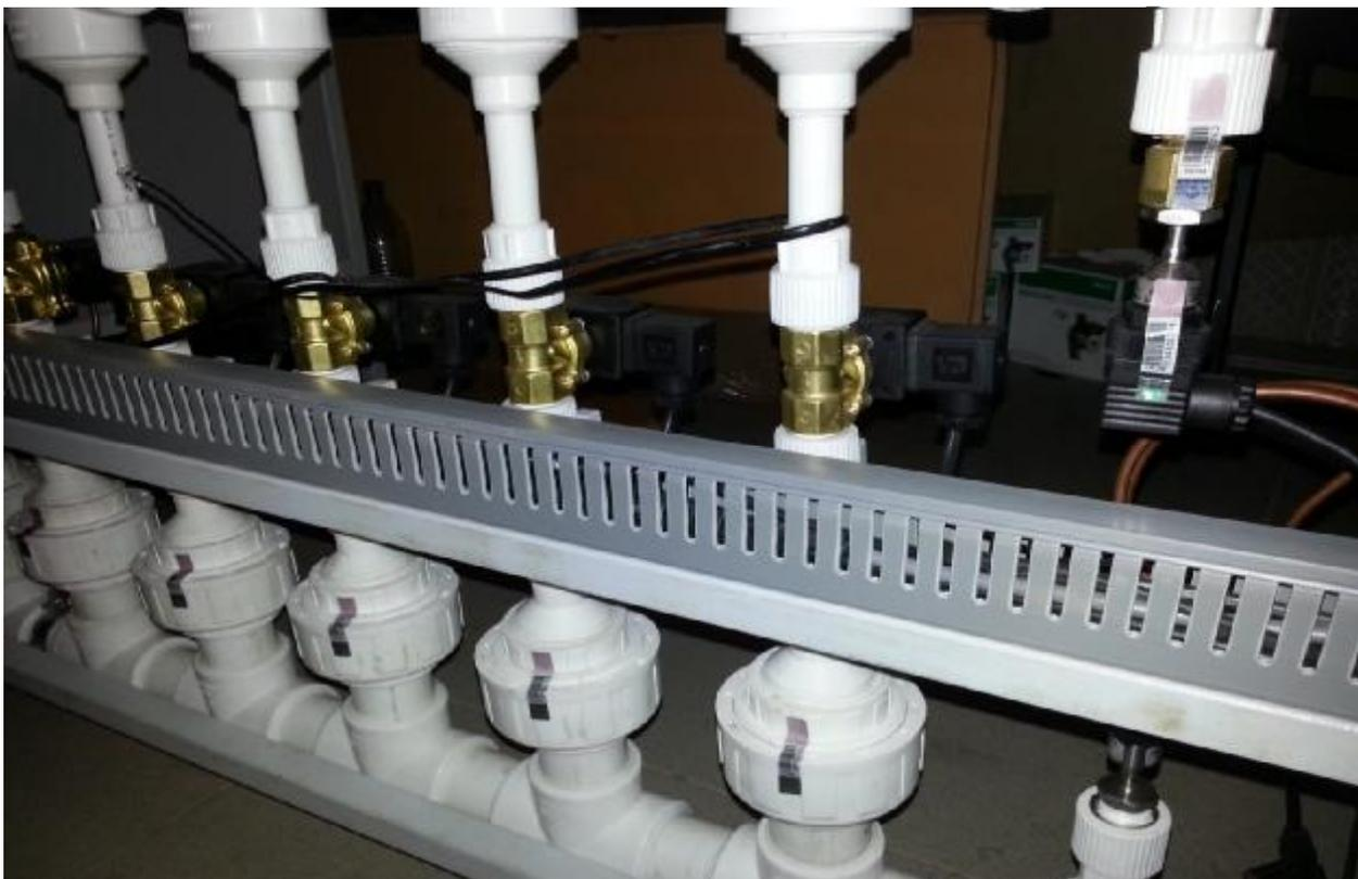
Рисунок 3 - Пломбирования датчика температуры
