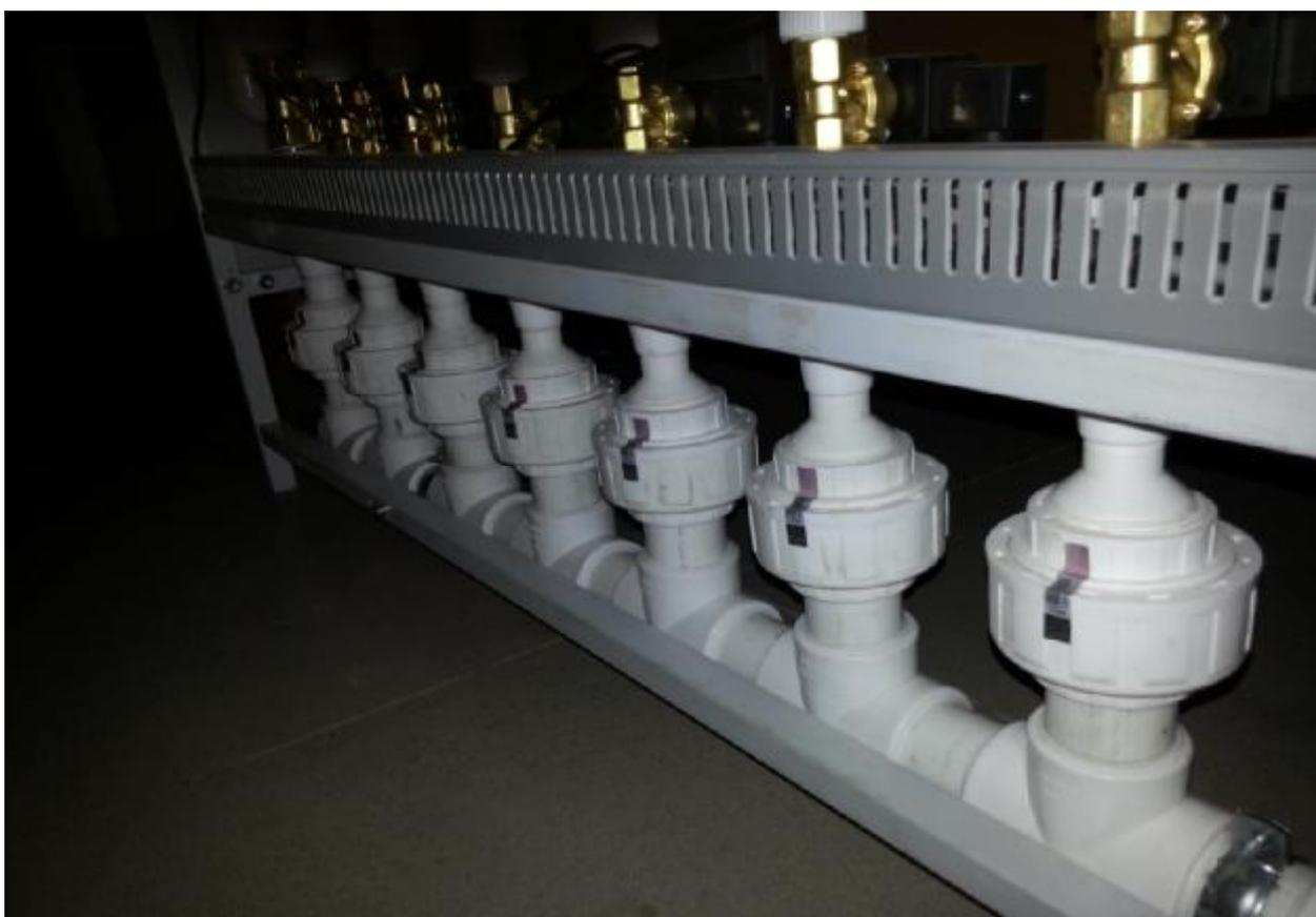
Рисунок 4 - Пломбирования мест установки сопел
