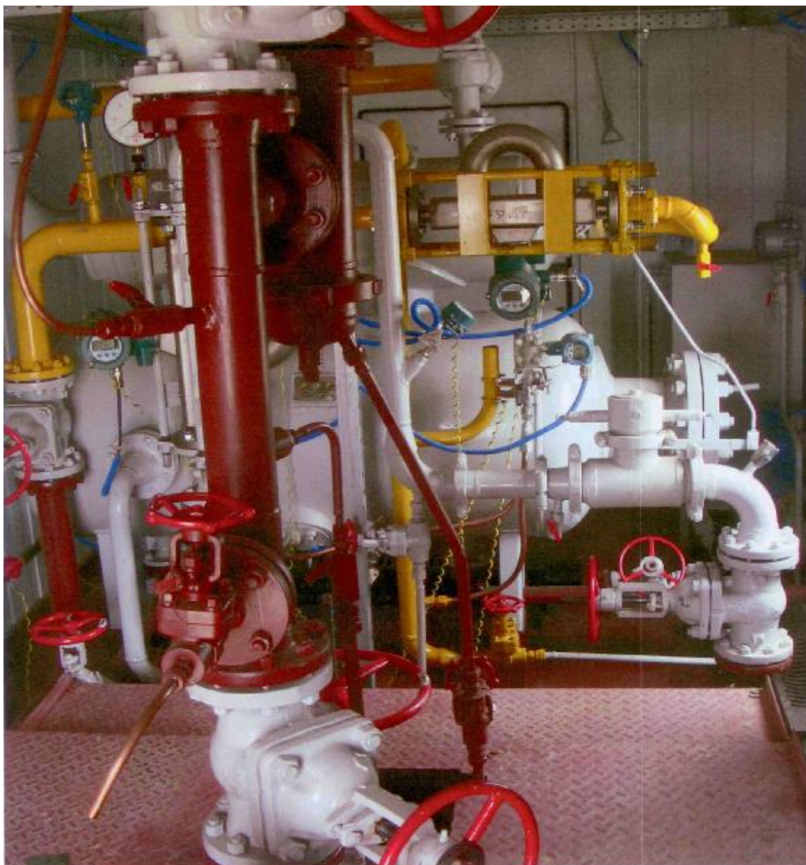
Рисунок 1 – АГЗУ Спутник с комплексом измерительно-вычислительным «ИВК «Мера-ММ» Схемы пломбирования контроллеров представлены на рисунках 2 – 4.
