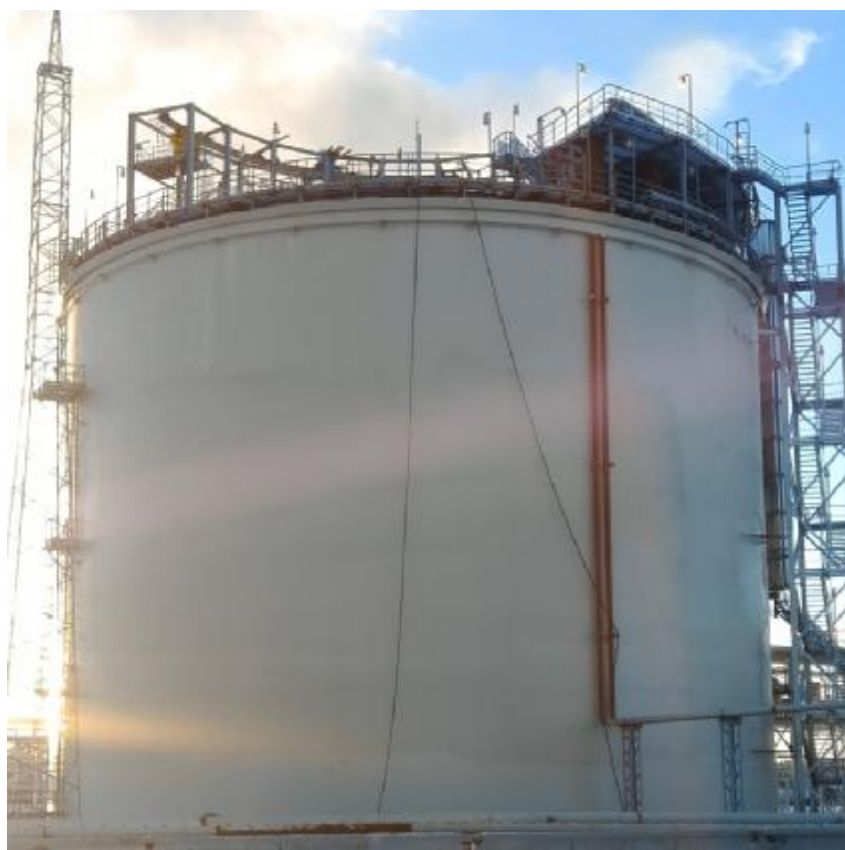
Рисунок 2 – Общий вид резервуара Е-8
