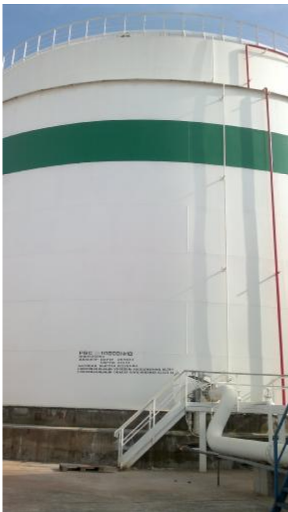
Р и с у н о к 1 – Общий вид резервуара вертикального стального цилиндрического РВС-10000, зав. № 10.
