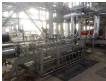
Блок измерительных линий ГФ СУГ
