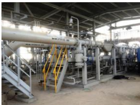
Блок измерительных линий ЖФ СУГ
