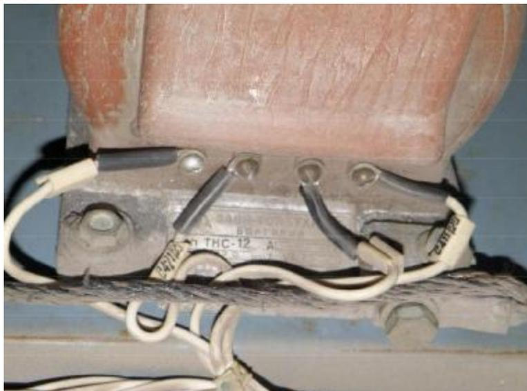
Рисунок 1 - Фотографии общего вида трансформаторов тока ТКС-12
