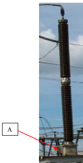
Рисунок 1 - Общий вид средства измерений и обозначение места пломбировки от несанкционированного доступа (А)
