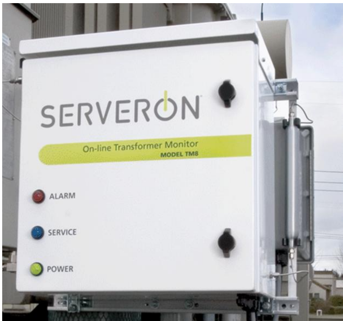
Рис.1 Фотография общего вида хроматографа Serveron модель ТМ8.
