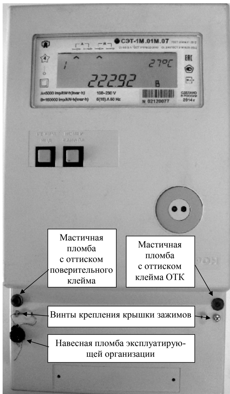
Рисунок 1 - Внешний вид счетчика с установленной крышкой зажимов
